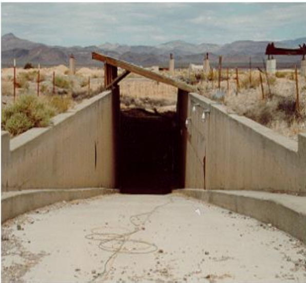
現在の地下ガレージ/シェルターの入口
