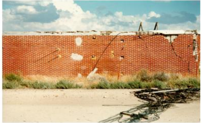
実験後の窓のないモジュール構造物。壁の変位に注意。
