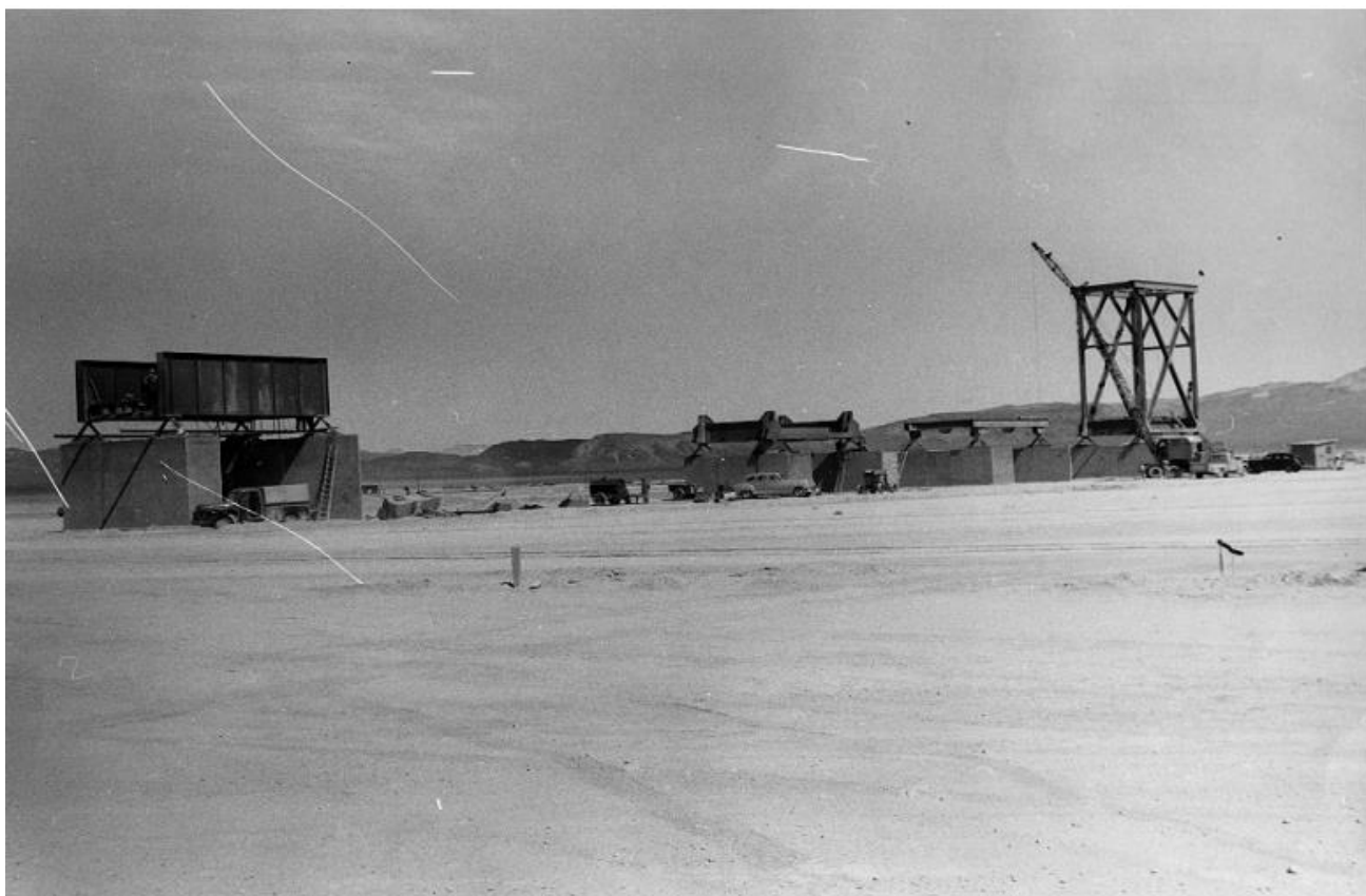
Encore 実験に備える4つのオープンフレーム構造物。左遠方の単線鉄道橋は、上部構造以外は今日も残存している。構造物は Encore 爆心から 660 メートル地点にある。
