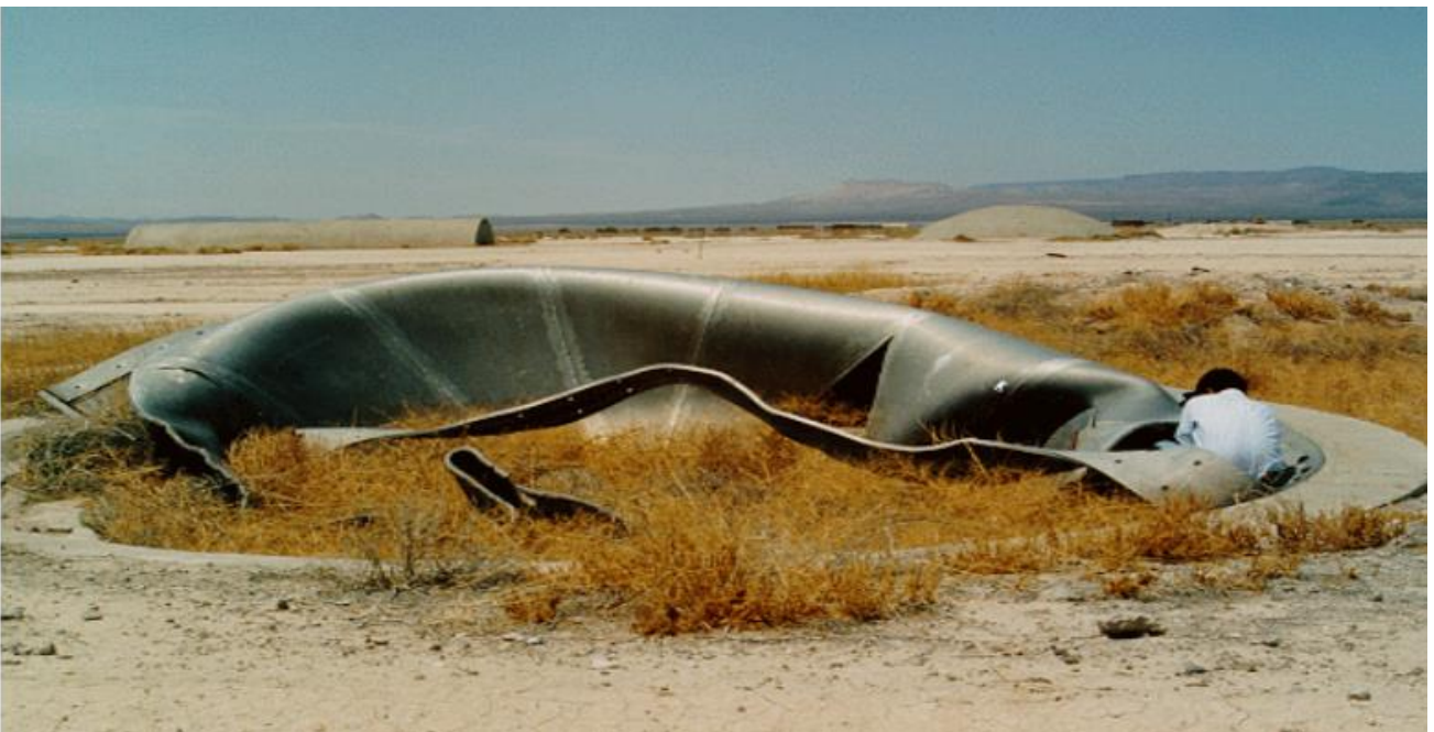
崩壊した2個のアルミニウムシェルターのうちのひとつ。
