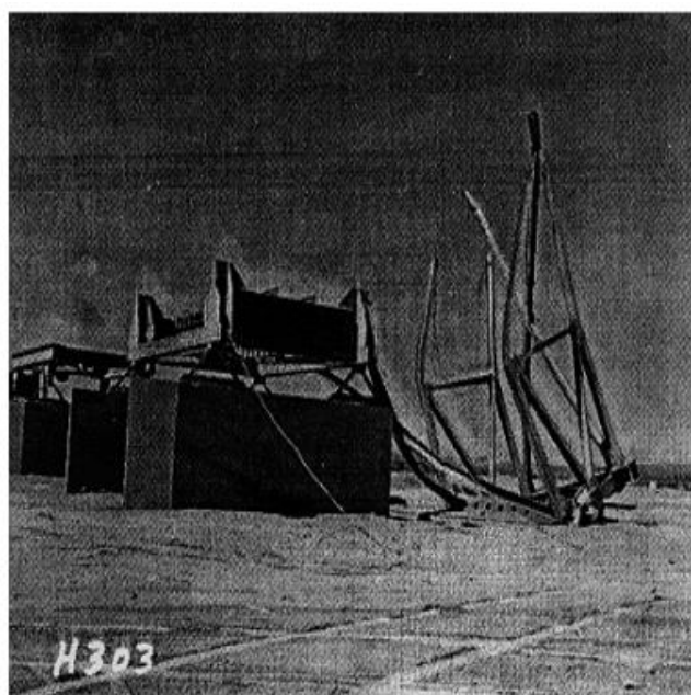
Encore 実験後のオープンフレーム構造物
