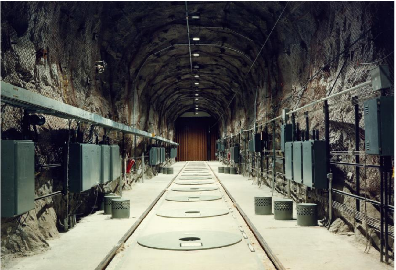
Spent Fuel Test (Climax Mine) : エリア 10 の 10-02 道路の終端
