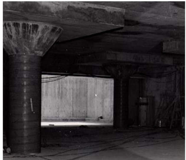
27メートル四方の2目的のガレージと大型シェルターの内部
