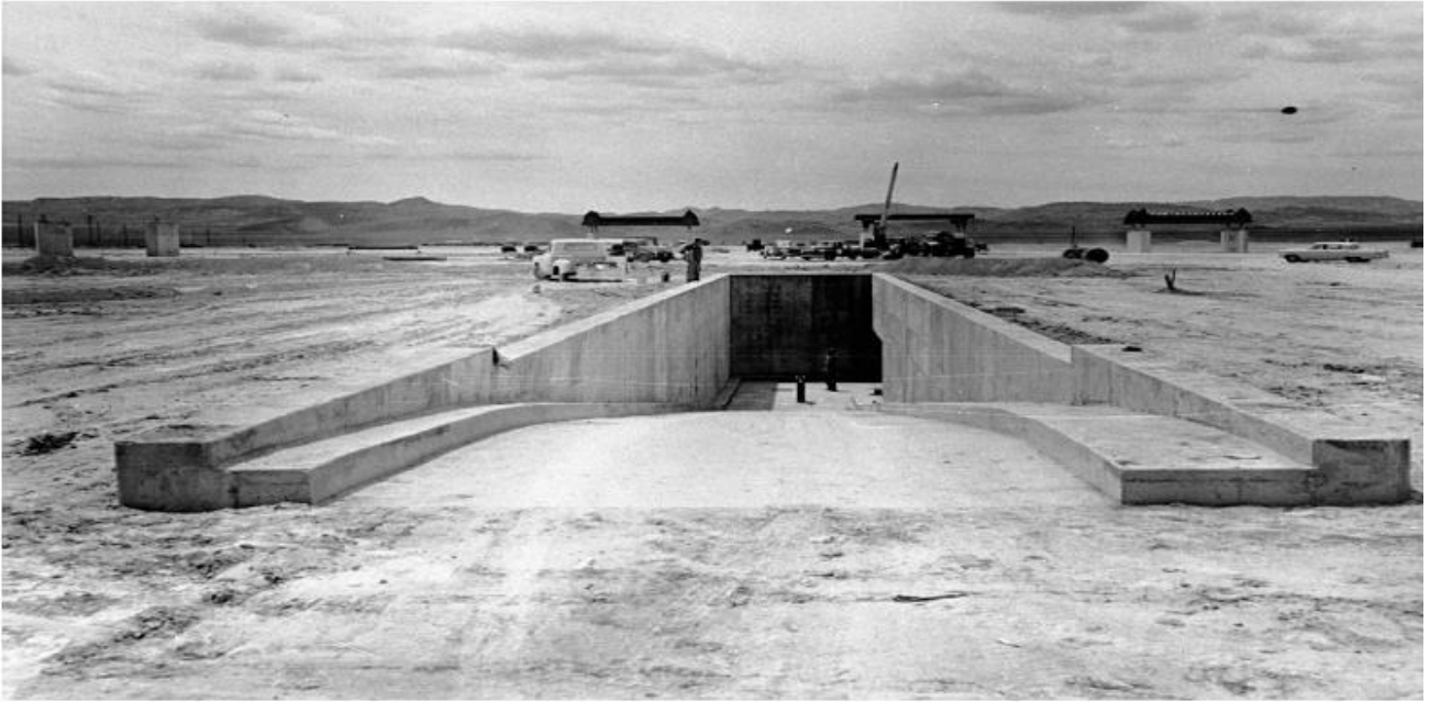
1957年当時の地下ガレージ/シェルターの入口
