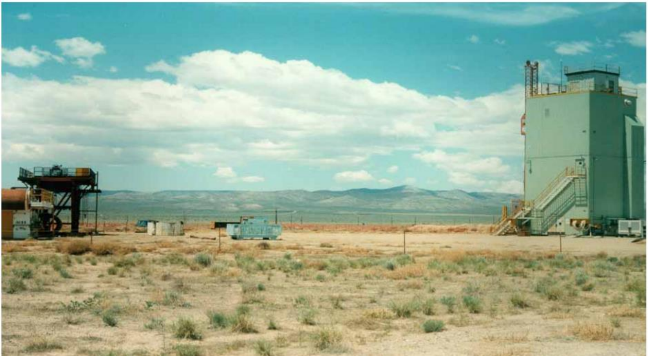
フォーチュン訓練塔：エリア6の Tweezer 道路の西
