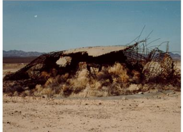
1957年当時のドーム型コンクリートシェルター 崩壊した厚さ15cmのコンクリートドームの入口。
