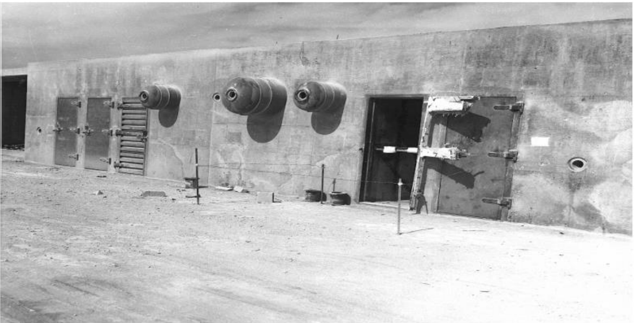
1953年の Encore 実験直後の工業建築物の一つ ( Motels )
