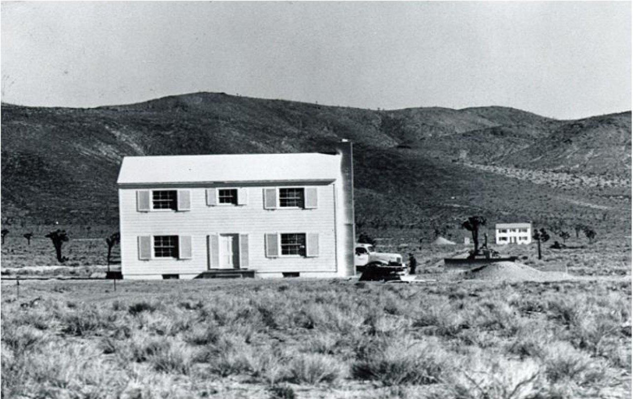
破壊される直前のエリア 3 Annie 住宅
