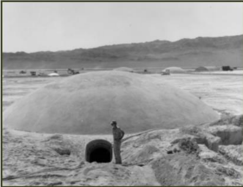
1957年のプリシラ実験前のコンクリート製 シェルタードーム
