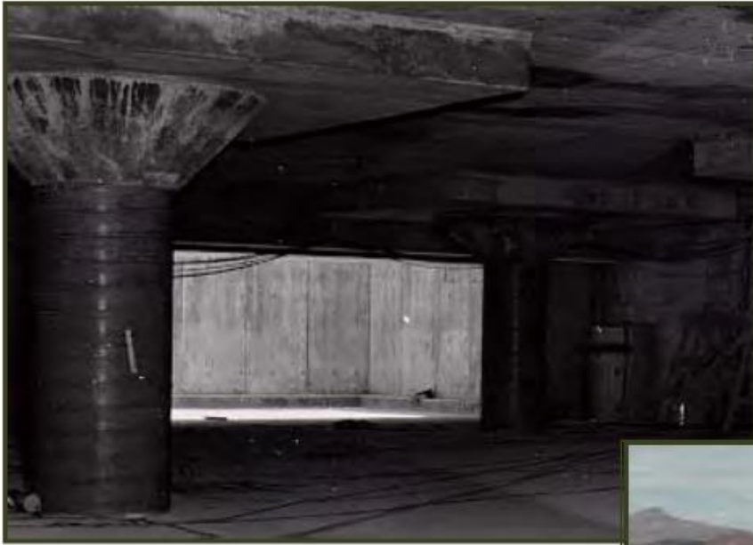
プリシラ実験のために建設された 80㎡の二目的の地下ガレージ及び 大規模シェルター
