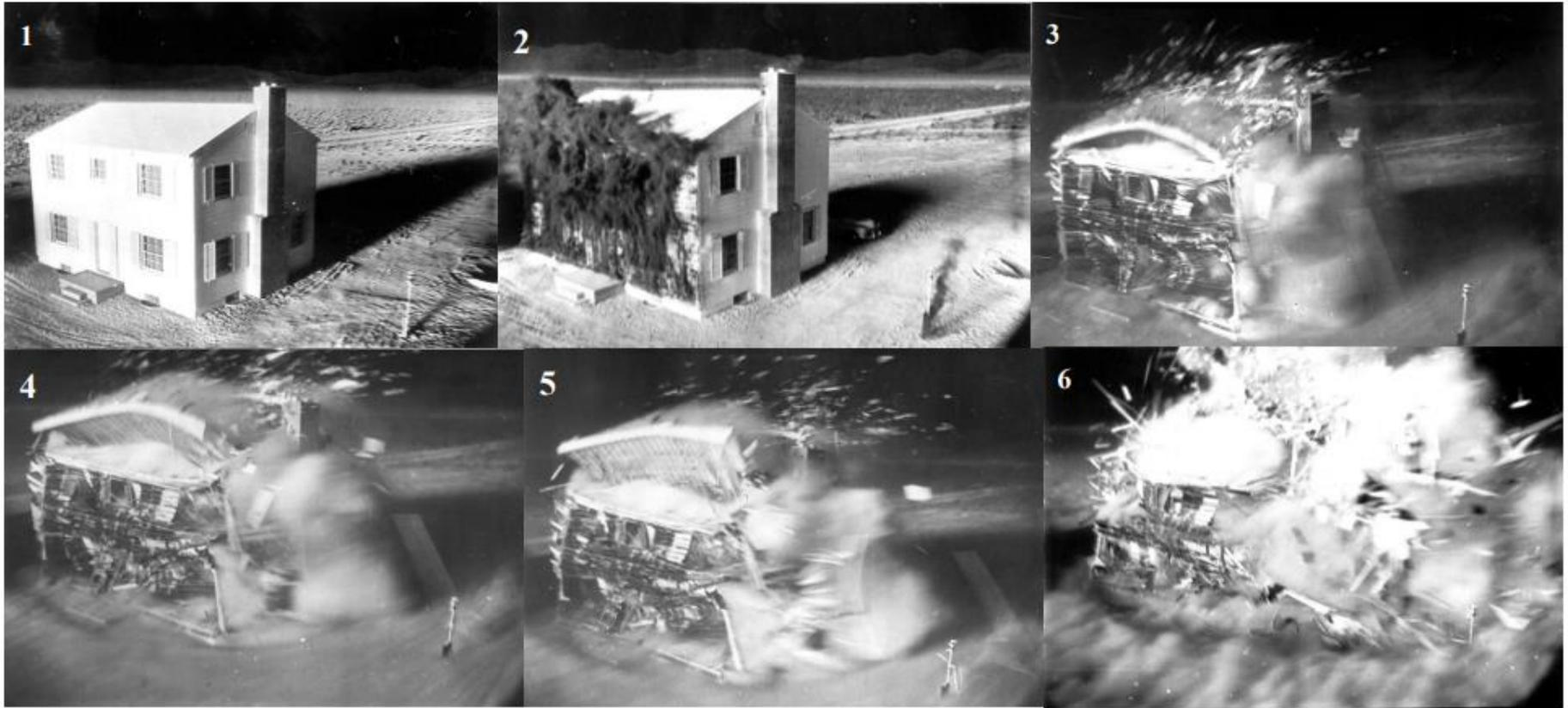
アニー爆心から1050mの地点に位置するコロニアル様式の住宅が完全破壊される様子を示す連続写真
