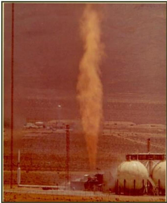
PHOEBUS 2Aは飛翔しない核ロケット反応炉として作られた中で最も高出力。反応炉は32分間稼働。12分間は100万ワット以上の出力
