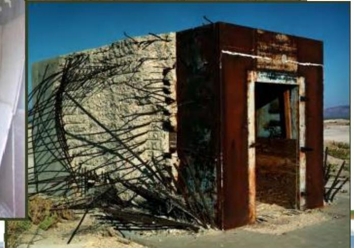
1957年のプリシラ実験のためにモスラー金庫会社が設計した3.6m×2.4mの鉄筋コンクリート造の金庫室。鋼鉄の扉のトリムは爆発で緩んだが、扉自体は損傷していない。金庫内に格納された物は損傷していない。
