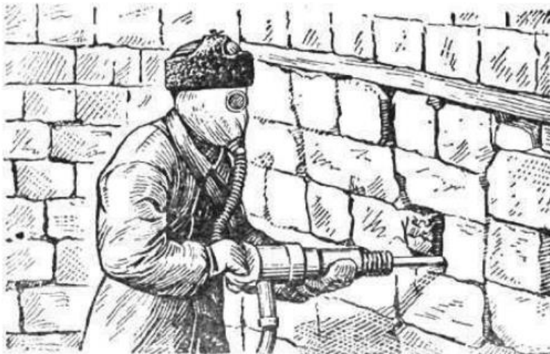
図 36. シェルターの壁に穴を開ける
